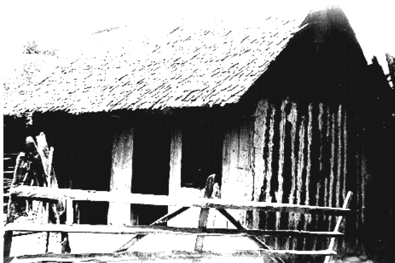
Fig. 10. Odaia lui Costică Jghianu, vedere generală, Năruja
