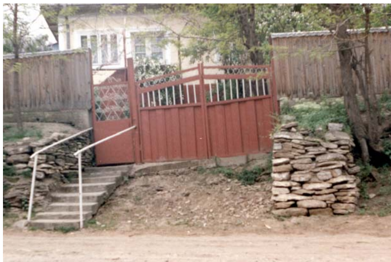
Contraforți din piatră la garduri, Deleni
