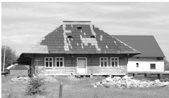
Fig. 8. Casă cu învelitoare din draniță parțial înlocuită
