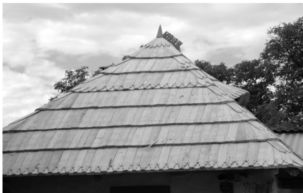
Fig. 9. Anexă cu învelitoare din draniță în curs de tratare
