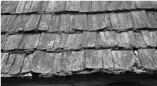
Fig. 4. Învelitoare din draniță cu vegetație de mușchi
