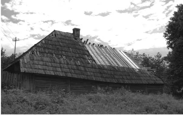
Fig. 3. Recondiționarea unei învelitori de draniță
