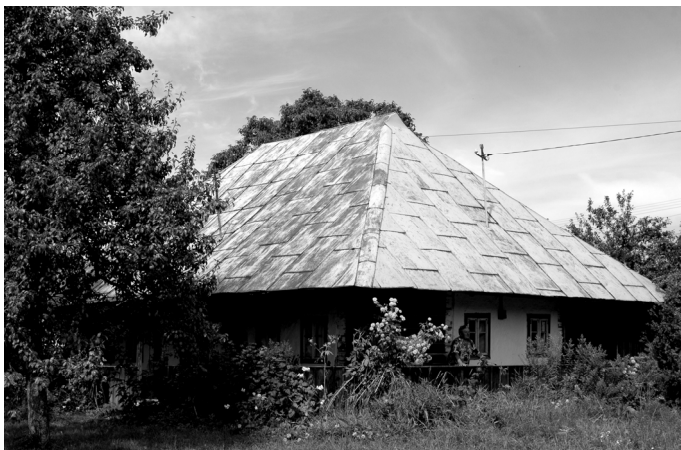
Fig. 1. Înlocuirea draniței de pe casă cu învelitoare din tablă
