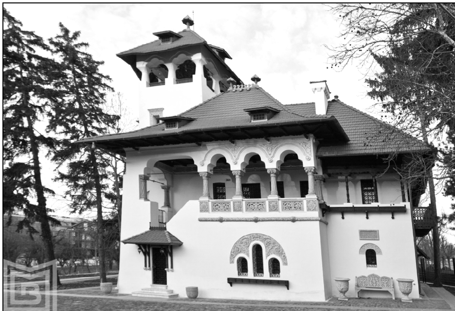
Fig. 2. „Vila cu clopoței” după restaurare și reconsolidare (fațada estică)
