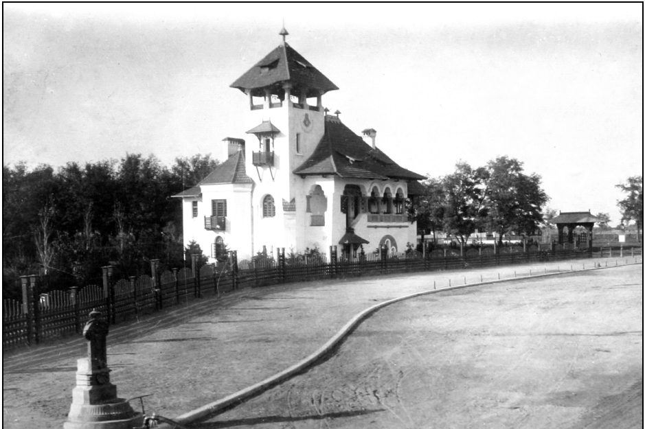
Fig. 1. Vedere cu „Vila cu clopoței” dinspre Șoseaua Băneasa în anul 1912 43
