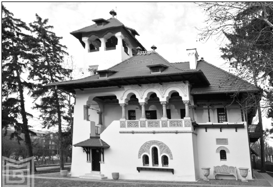
Fig. 2. „Vila cu clopotei” după restaurare și reconsolidare (fațada estică)
