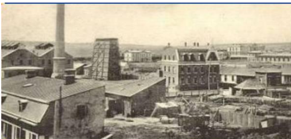
Uzina de Lumină înainte de intrarea în funcțiune (1899). În stânga – Stația de 6 KV, la mijloc, în spate – Sala Cazanelor, În dreapta – Clădirea administrativă și locuința directorului.
