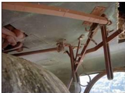
Fig. 2. Clopotul orar din Turnul Casei Sfatului (vedere a sistemului de pârghii pentru acţionarea ciocanului bătător)
