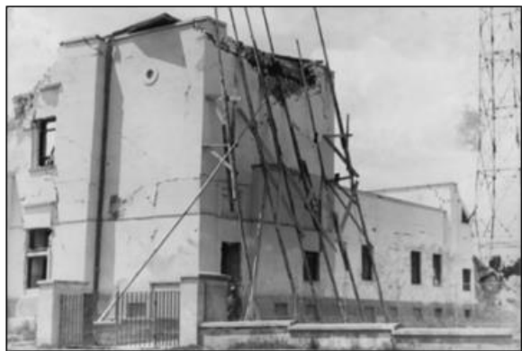
Fig. 3. Clădirea Radio Basarabia, 1941.
