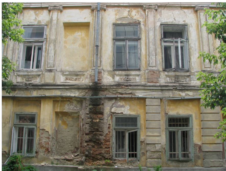
Fig. 6. Aspectul fațadei de nord, dinspre Universitatea „Petre Andrei”
