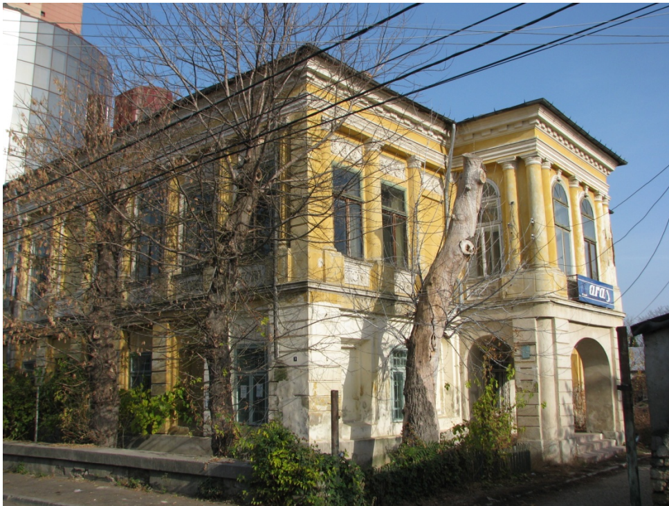
Fig. 1. Casa Burchi-Zmeu. Vedere dinspre sud-vest
