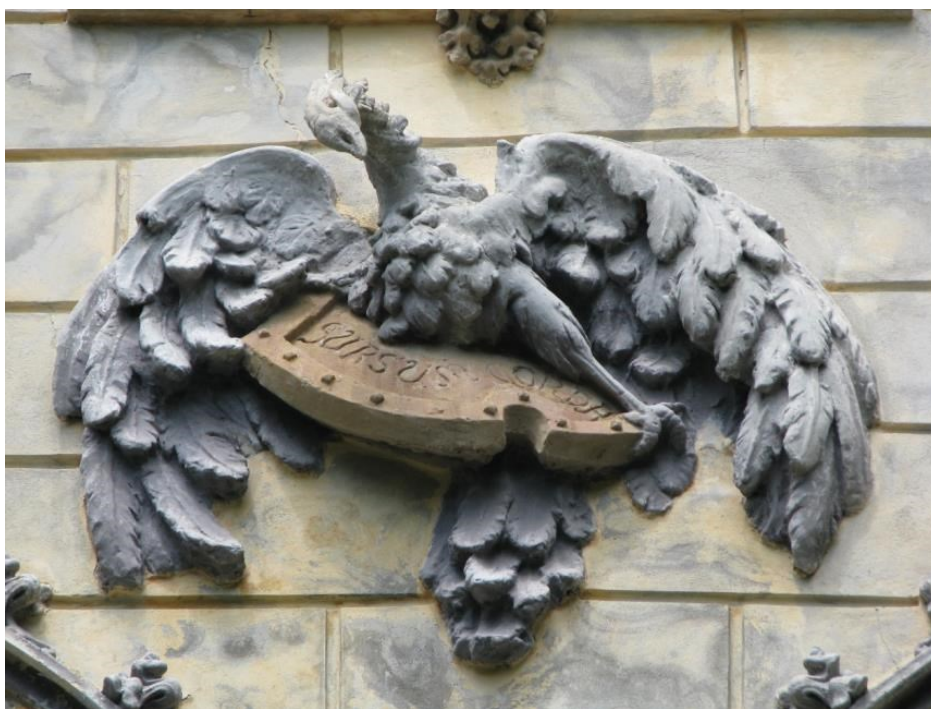
Fig. 6. Deviza „Sursum corda” de pe fațada de sud
