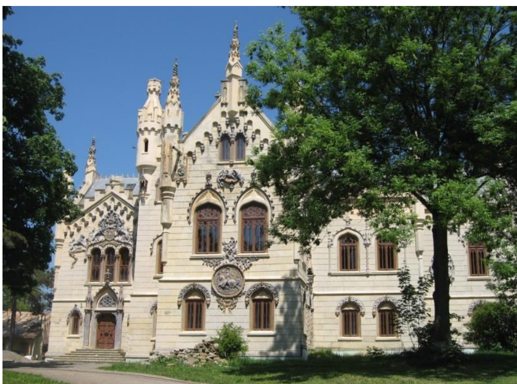
Fig. 1. Castelul de la Miclăușeni, fațada de sud
