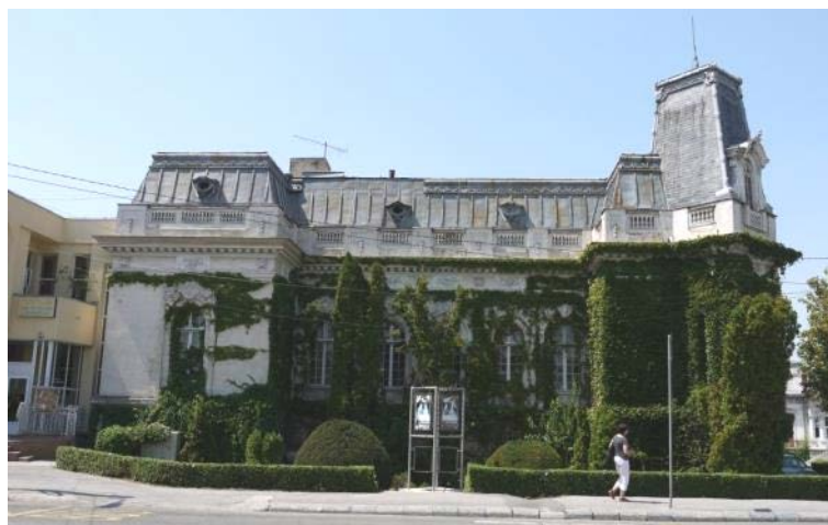
Fig. 8 - Alipirea Casei de Cultură de Casa Alexandru Poenaru. Foto Sidonia Teodorescu, 2012
