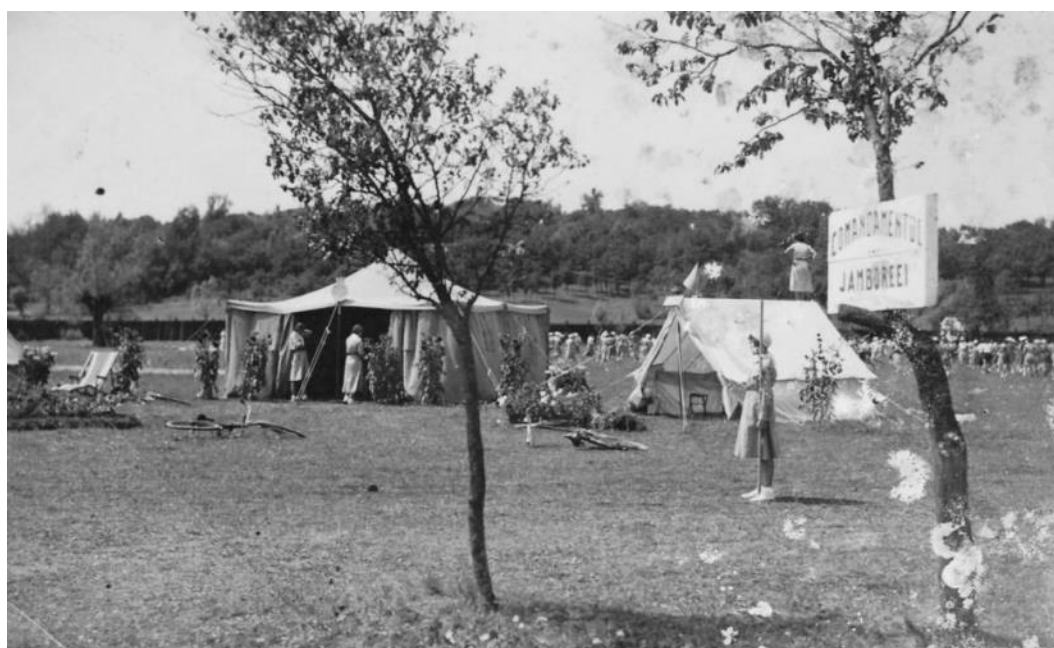
Fig. 13 – Comandamentul Jamboreei Cercetaşelor
