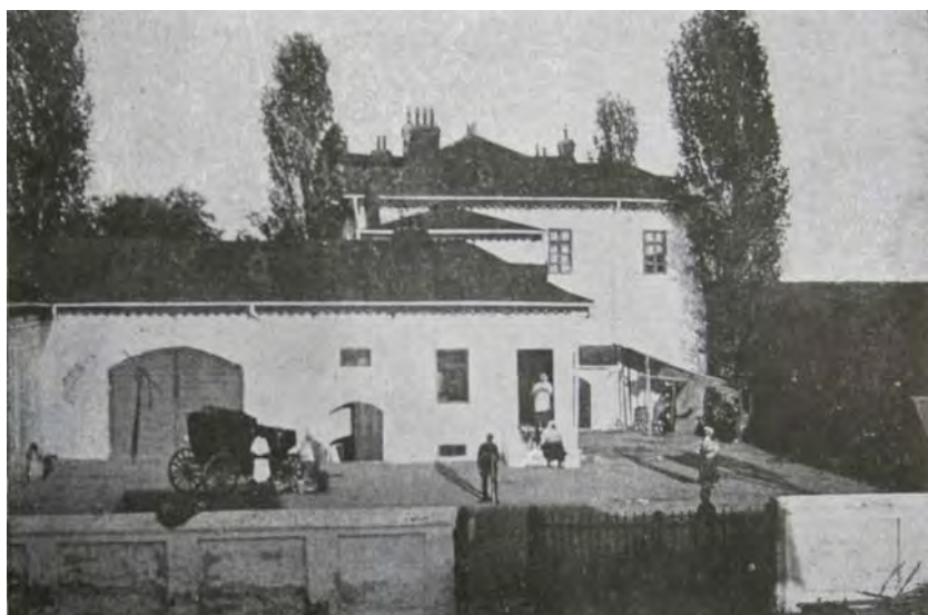
Fig. 7. Conacul de la Dobrotești. Vedere laterală ( Ilustrațiunea , București, 1925)
