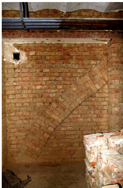
Fig. 4. Arcele mari de descărcare din subsol
