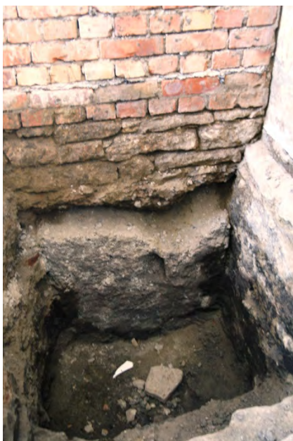
Fig. 18 a. Zidăria și fundația Palatului Culturii în punctul de racord cu colțul nord-vestic al Palatului Ocârmuirii
