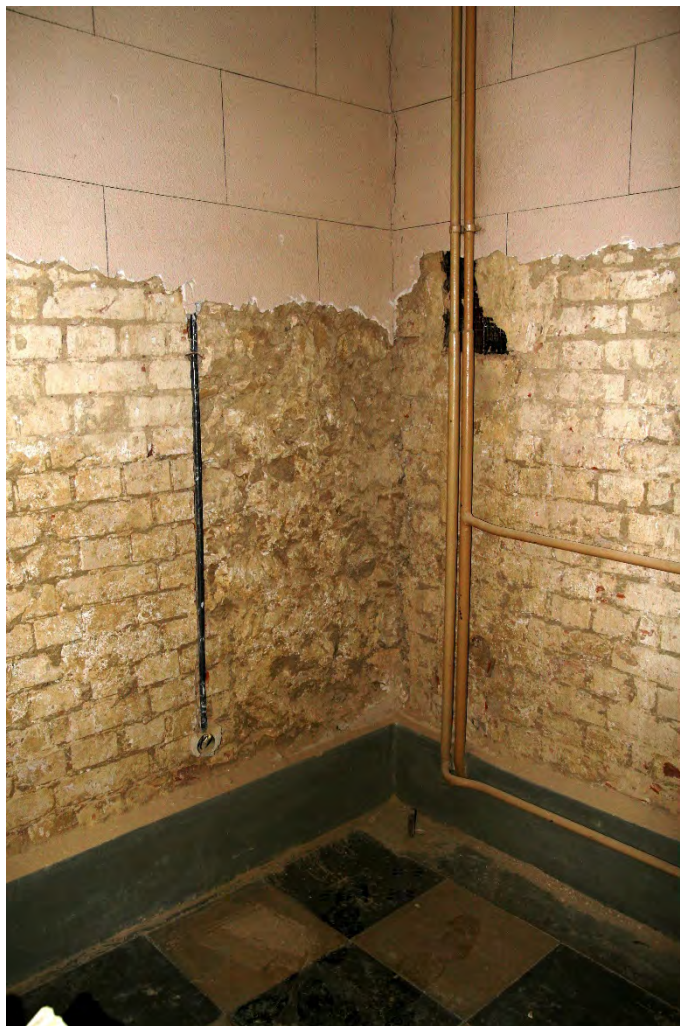
Fig. 19. Întreruperea zidului de piatră în încăperea P. 79
