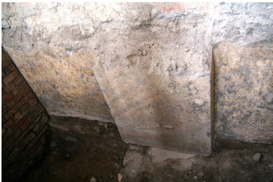
Fig. 20. Sistemul de finisare a fațadelor Palatului Ocârmuirii, soclul său simplu și rezalitarea îngustă
