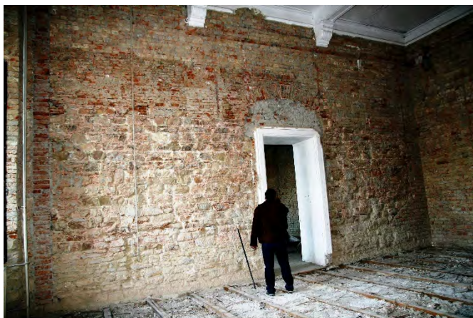
Fig. 9. Nivelul de păstrare a zidărilor de piatră
