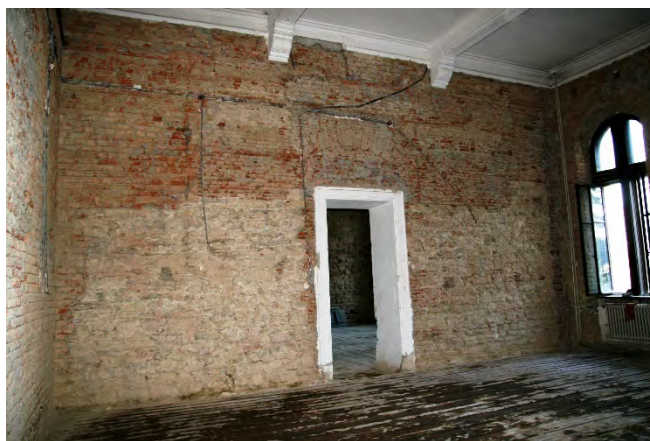
Fig. 8. Nivelul de păstrare a zidărilor de piatră
