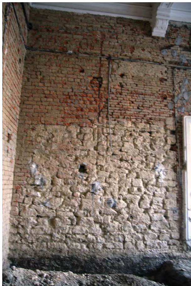
Fig. 11. Sistemul de „așezare” a zidurilor actualului edificiu peste vestigiile păstrate din Palatul Ocârmuirii
