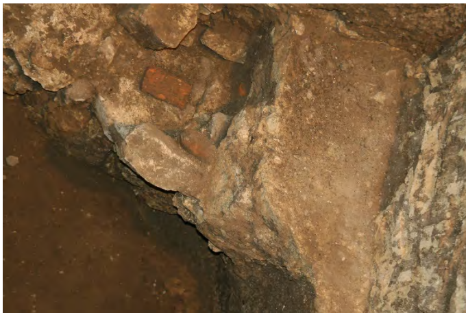
Fig. 38. Secțiunea S. 02/2009, detaliu asupra golului de tirant din zidul Z.03
