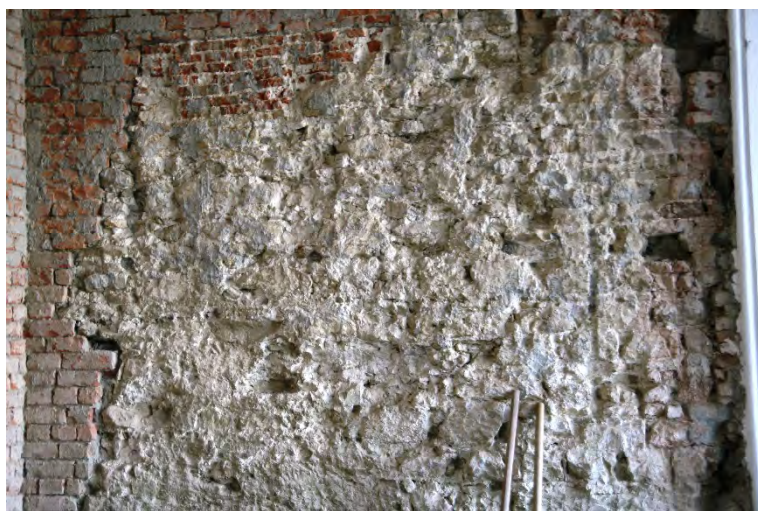
Fig. 21. Zonele pereților de est (a) și de vest (b) ai încăperii P. 88, unde grosimea zidurilor de piatră a fost diminuată prin spargere
