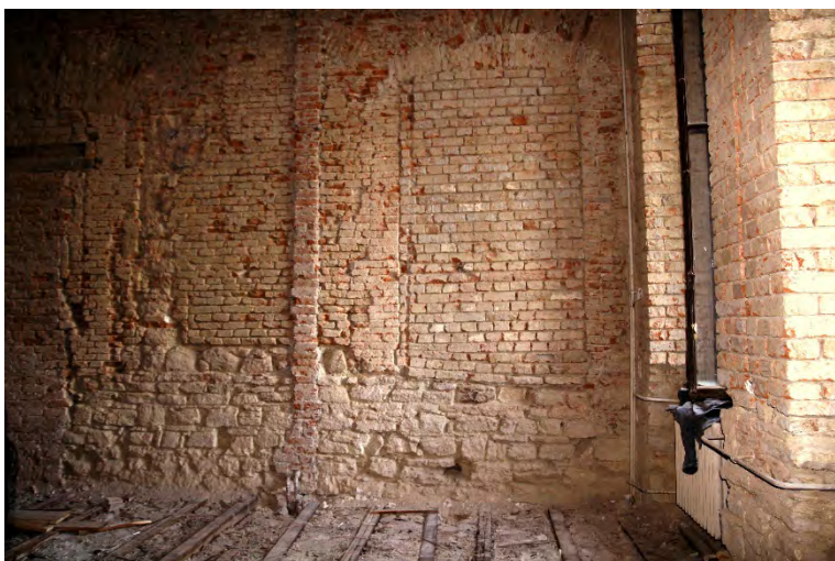
Fig. 14 (a, b). Exemple de umplere a unor goluri cu materiale foarte diverse: fragmente de piatră și fragmente din cărămizi de format diferit
