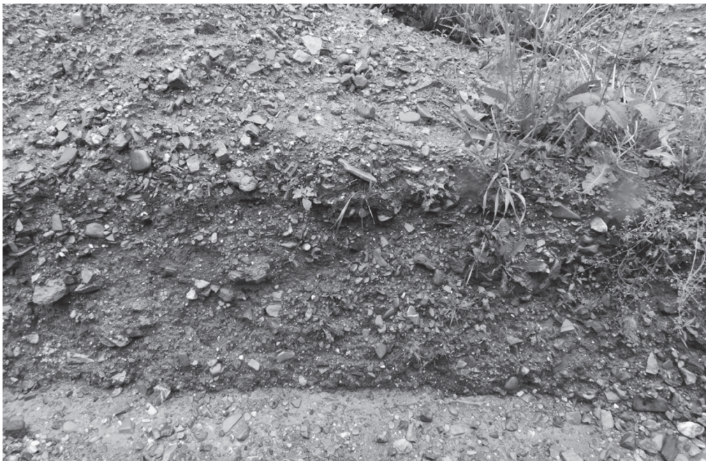
Fig. 22. Zona turnului de N-E, latura de N.
