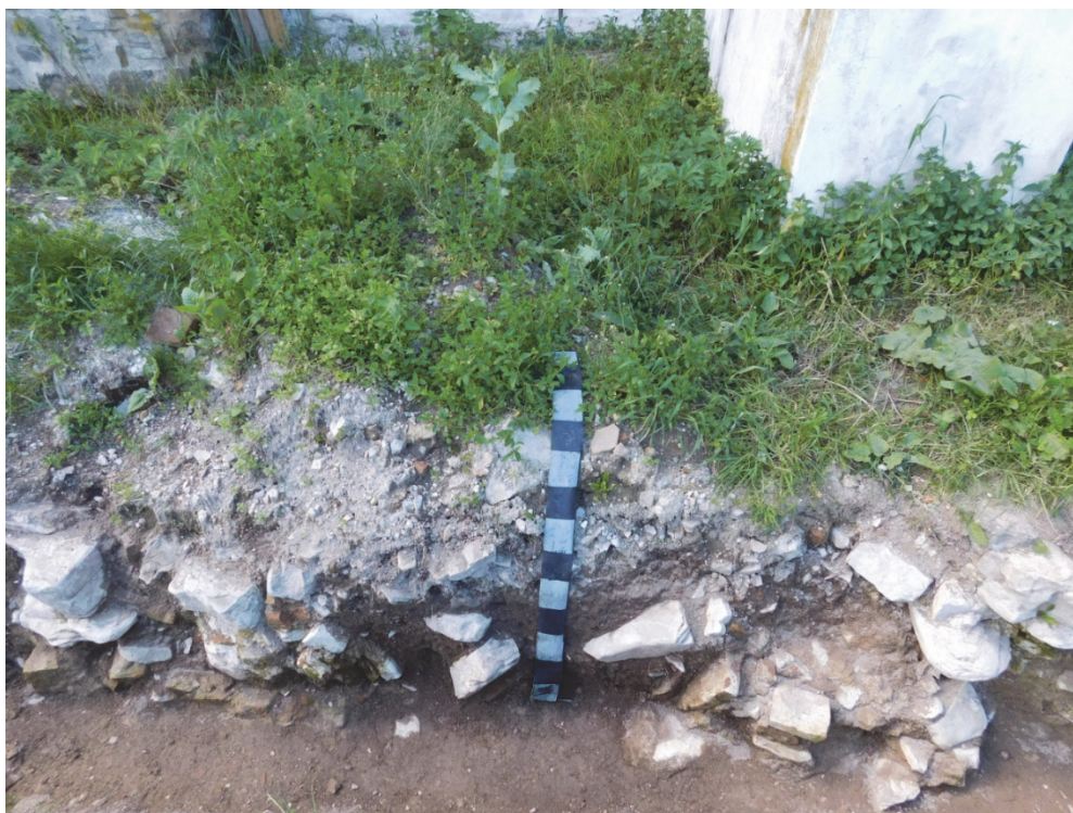
Fig. 19. Pinteni de zid . Zona Contra foc II, latura de E.
