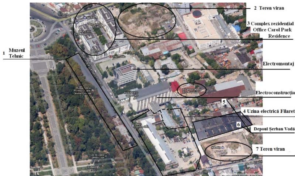
Fig. 4. Muzeul Național Tehnic (1) și vecinătățile - Uzina Electrică Filaret (4), Depoul Șerban Vodă (5, 6), terenuri virane (2, 7) și Complex rezidențial (3).
