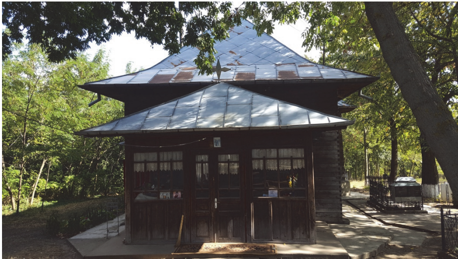
Fig. 7. Biserica de lemn din Tanacu. Vedere de pe latura vestică (octombrie 2017)
