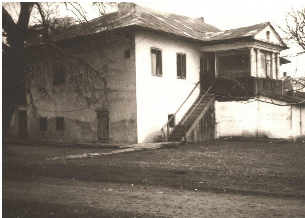
Fig. 51. Fosta stăreție a Mănăstirii Bărboi, vedere dinspre sud-est
