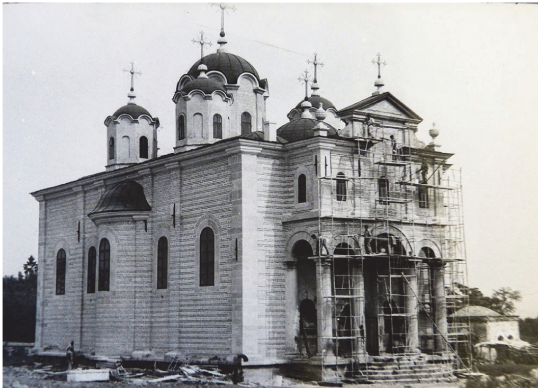
Fig. 39. Restaurarea bisericii Bărboi (c. 1980). Vedere dinspre nord-vest
