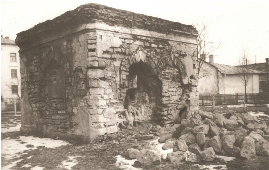
Fig. 44. Cişmeaua de la biserica Bărboi. Vederea conductelor metalice
