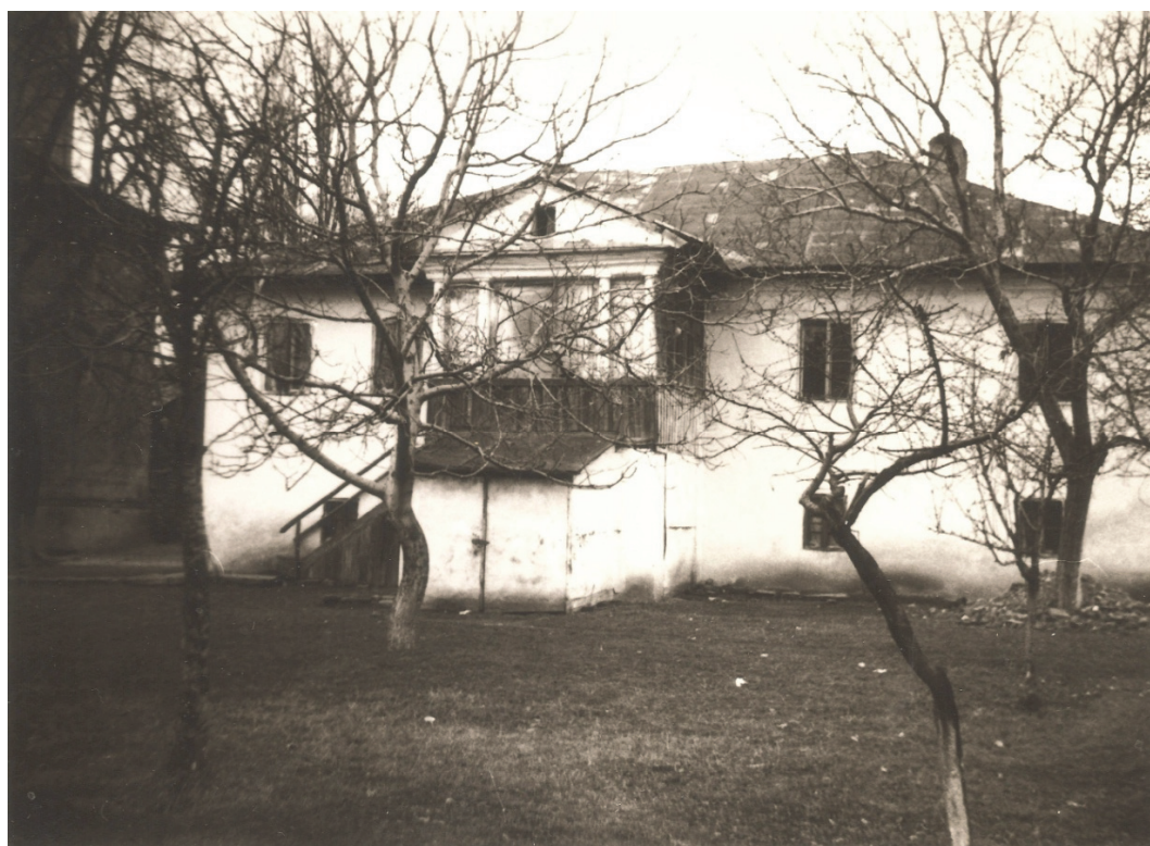
Fig. 52. Fosta stăreție a Mănăstirii Bărboi, vedere dinspre est
