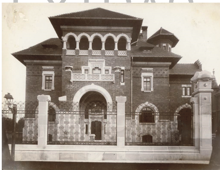
Fig. 14. Casa generalului Radu Rosetti și a Ioanei Știrbey din București (strada Mihail Moxa). Colecția arhitect Mădălin Ghigeanu
