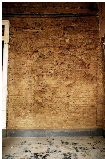
Fig. 16. Exemple de umplere a unor goluri cu materiale foarte diverse: fragmente de piatră și fragmente din cărămizi de format diferit
