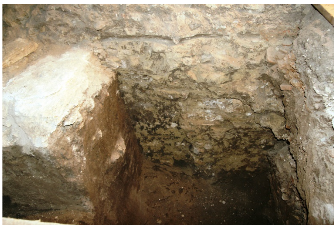
Fig. 30. Secțiunea S.01/2009, vedere asupra zidului Z.02
