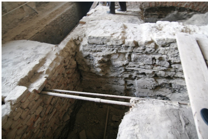
Fig. 26. Canalul amenajat inițial pentru montarea instalației termice a Palatului Culturii
