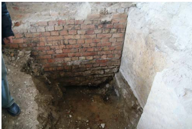
Fig. 18 a. Zidăria și fundația Palatului Culturii în punctul de racord cu colțul nord-vestic al Palatului Ocârmuirii
