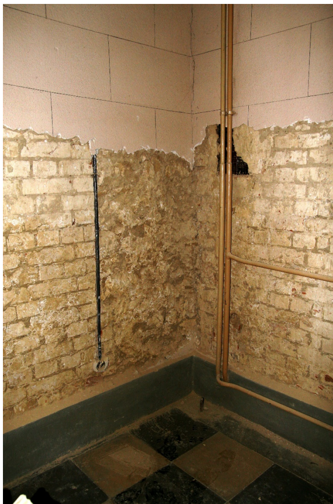
Fig. 19. Întreruperea zidului de piatră în încăperea P. 79
