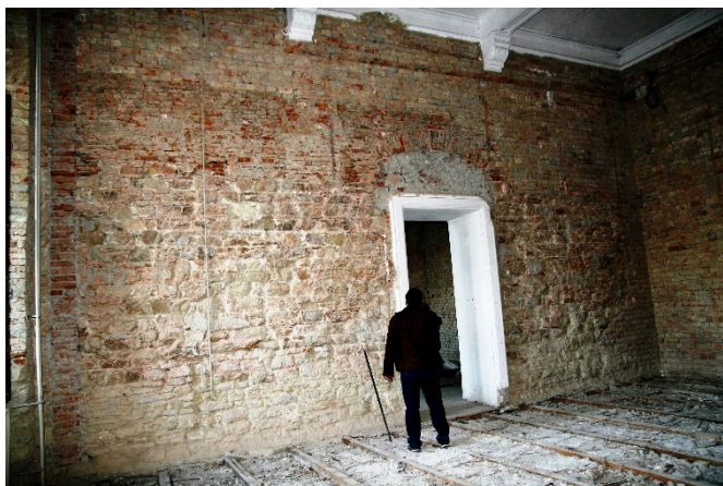
Fig. 9. Nivelul de păstrare a zidărilor de piatră
