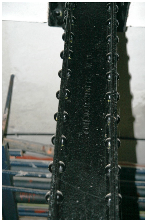
Fig. 6. Grindă de susținere a pasarelei de întreținere a centralei termice inițiale
