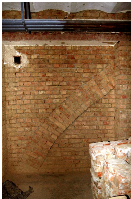
Fig. 4. Arcele mari de descărcare din subsol
