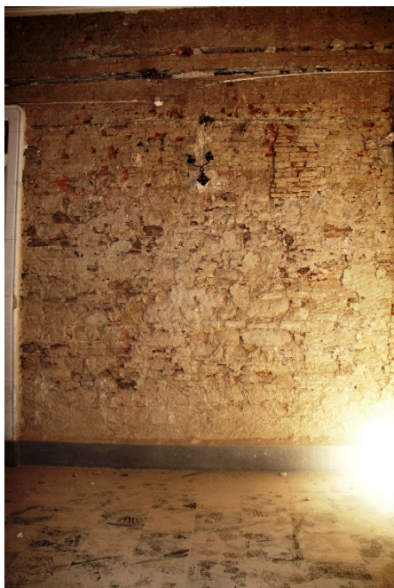
Fig. 15. Exemple de umplere a unor goluri cu materiale foarte diverse: fragmente de piatră și fragmente din cărămizi de format diferit
