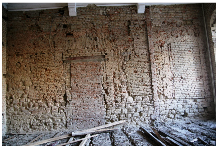
Fig. 24. Felul în care au fost umplute golurile la a căror folosire s-a renunțat
