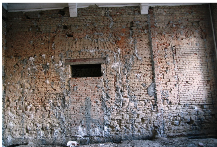
Fig. 25. Utilizarea buiandrugilor de lemn în umplerea unor goluri
