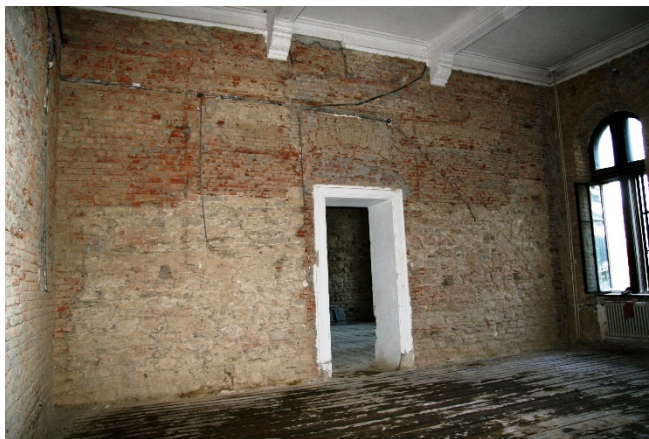
Fig. 8. Nivelul de păstrare a zidărilor de piatră
