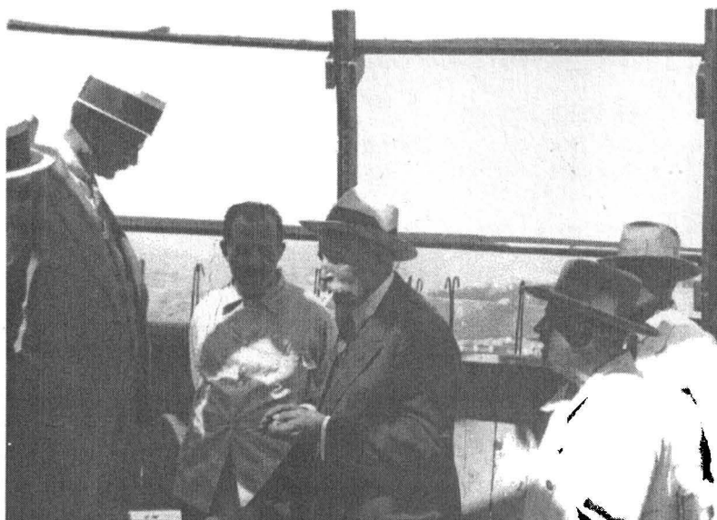
E. Ballif pe cupola Fundației Ferdinand, aflată în construcție
