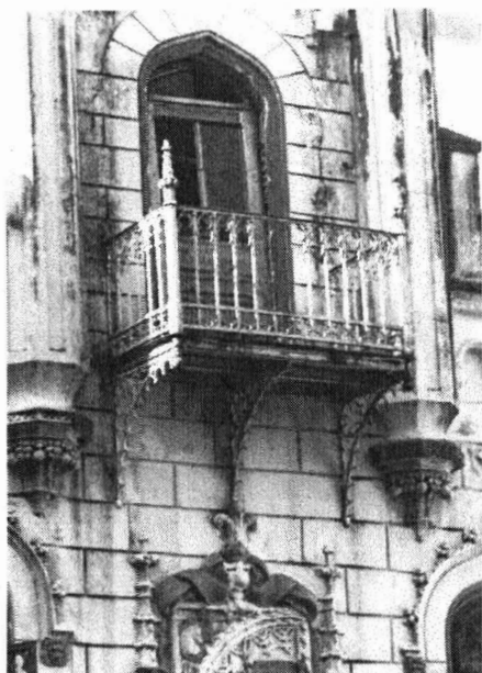
Foto 12. Castelul de la Miclăușeni, balcon executat în fier forjat
