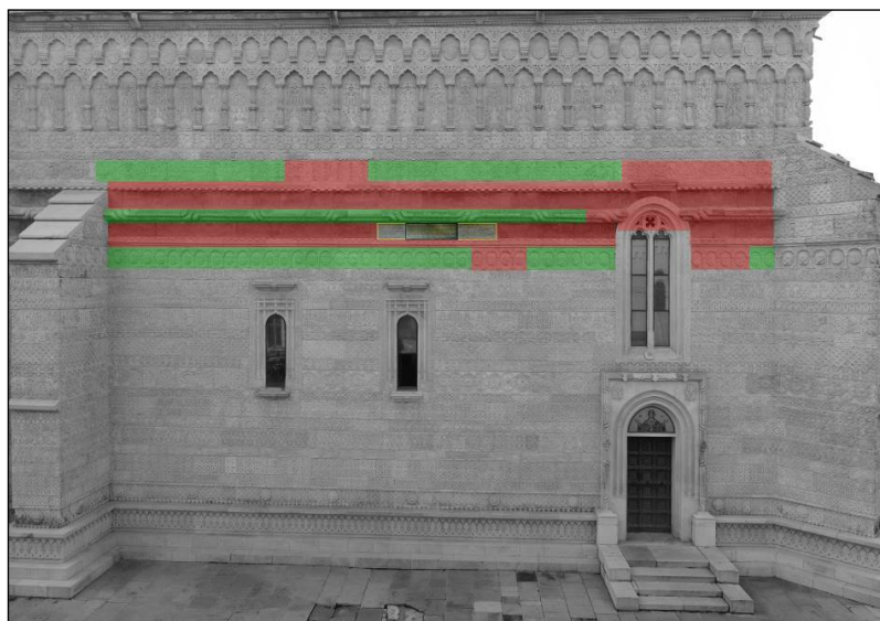
Fig. 23. Bandourile XVIII-XXII de pe latura de nord. Cu verde – zone cu ornamentația originală, de secol XVII; Cu roșu – zone în care ornamentația a fost refăcută în cadrul restaurării realizate de arhitectul francez; În chenar – plăcile din marmură neagră care poartă decor incizat cu urme din aur
