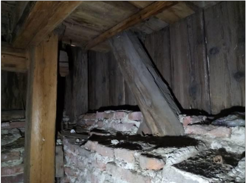
Fig. 20. Turnul-clopotniță. Structura „interioară” pentru nivelurile „camerei clopotelor” (în fața parapetului de zidărie) și cea a turnului (înglobată în zidărie) © Lucia Leca
