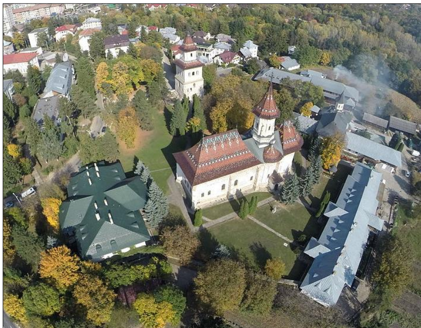
Fig. 1. Mănăstirea „Sfântul Ioan cel Nou” (fotografie aeriană Sc. AGD S.R.L. Suceava).
